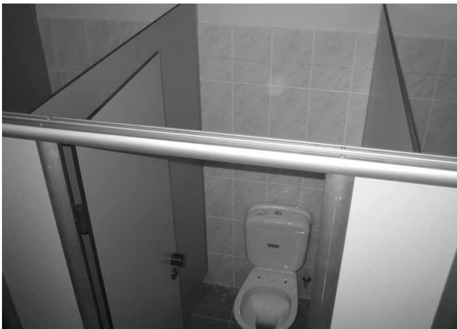
■ Die aus Deutschland erworbenen Toilettenkabinen sind eingebaut. Die Sanitärkeramik ist eine Spende der Firma DURAVIT.
