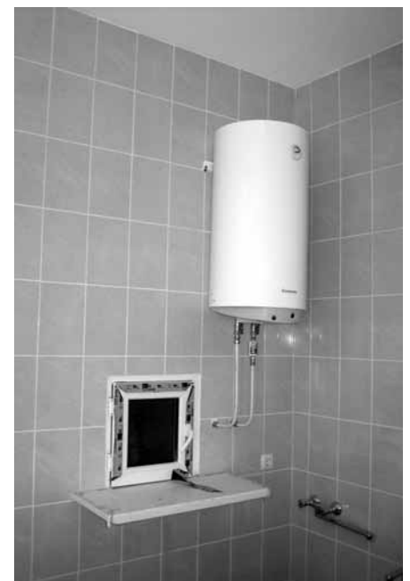
■ In der Küche ist der Elektroboiler fertig montiert. Bilder: Hartig
