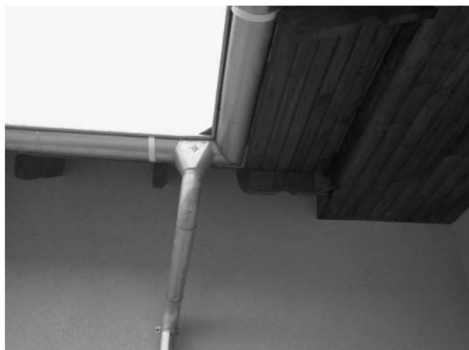
■ Die Dachrinnen sind mit dem entsprechenden Gefälle und Ablaufrohr, welches in die Ablaufdrainage führt, fertig montiert.
