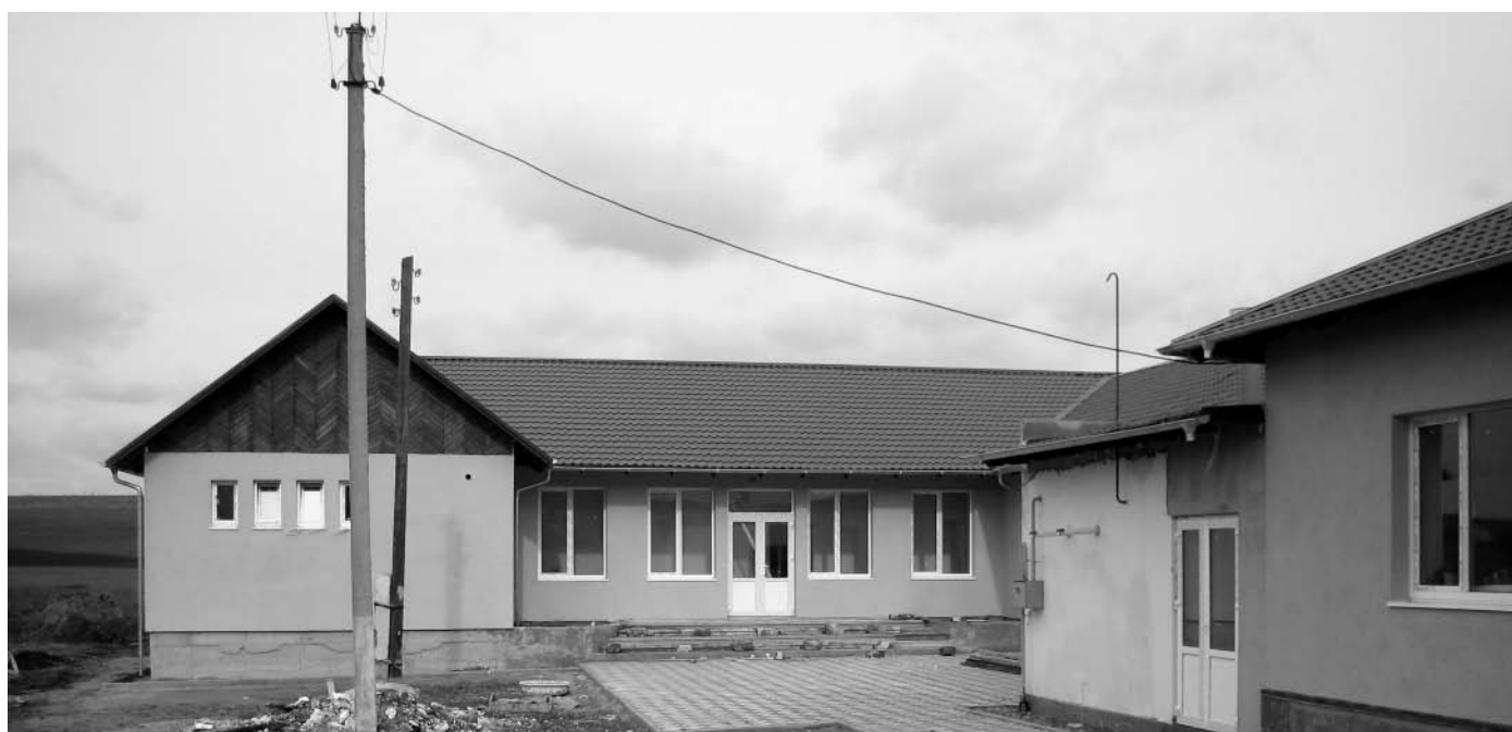
■ Linksseitige Ansicht des Schulbaues. Das Heizungshaus ist noch nicht verputzt.
