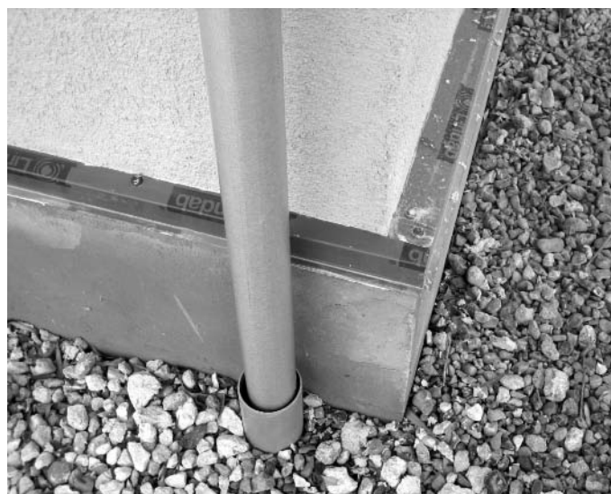
■ Das Regenablaufrohr führt in die Drainage. Die Abdichtung fehlt noch. Der Sockelvorsprung des Fundamentes wird mit Blech verkleidet, damit das Wasser, Schnee oder Frost den Putz nicht absprengt. Der Grundsockelputz muss noch angebracht werden. Der im Bild ersichtliche Kies sorgt dafür, dass das Oberflächenwasser in die unterirdische Drainage versickern kann. Bilder: Hartig
