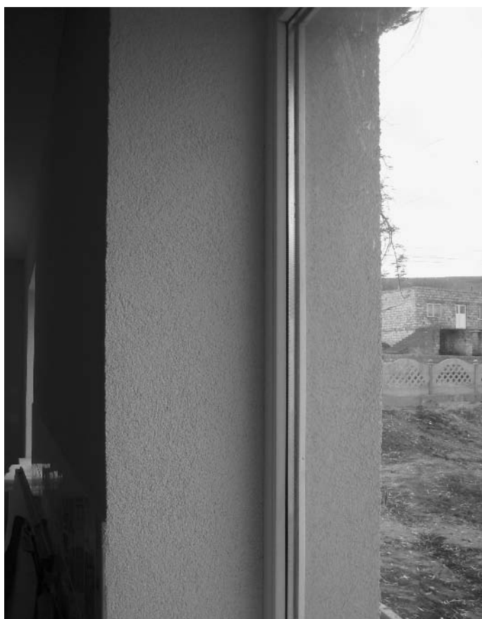
■ Blick vom Flur des Altbauteiles nach außen. Wir haben im Altbauteil sehr starke Wände vorgefunden. Innen und Außenputz mit einer 5 cm starken Isolation sind bereits fertig verputzt. Auf dem Bild ist unsere moderne Thermopenverglasung ersichtlich. Innen- und Außenputz stammen von der Fa. STO. Diese wurden unseren Farb Wünschen entsprechend dankenswerterweise als Spende zur Verfügung gestellt. Danke für dieses große Engagement.
