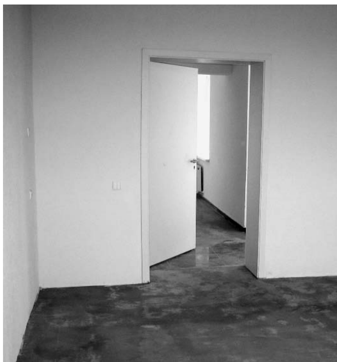
■ Blick von einem Klassenzimmer über den Flur in ein anderes Klassenzimmer. Noch ist der Linoleumboden nicht montiert, der Estrich ist bereits fertig. Die Räume sind hell und freundlich gestaltet.
