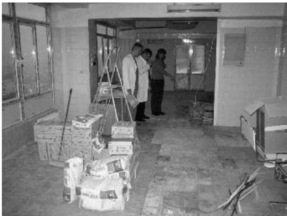
■ Die neuen Fliesen sind schon da und werden verlegt.
