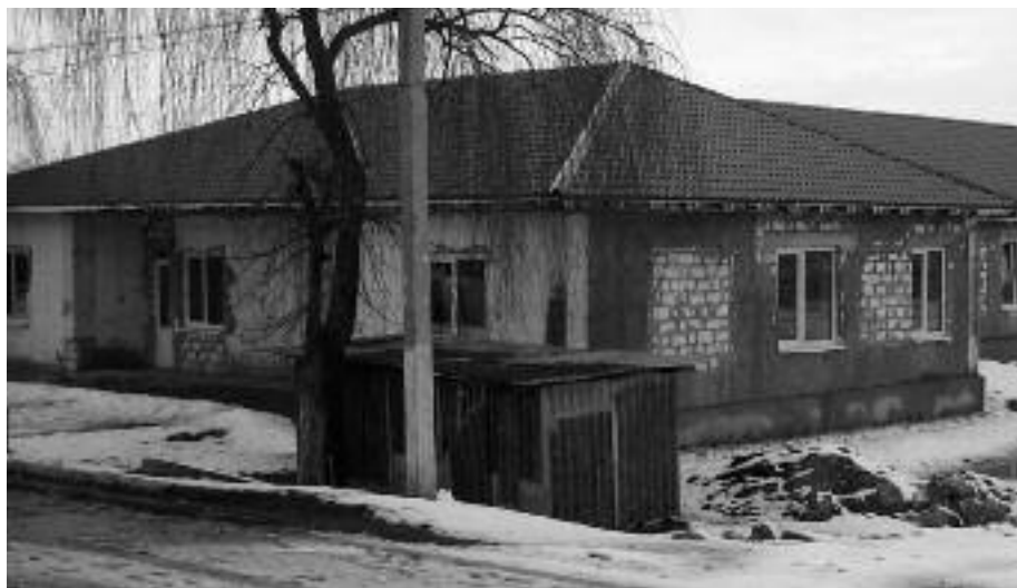
■ Auch der komplett sanierte Altbauteil der Schule Milestii-Noi ist geschlossen, Bild: Hartig
