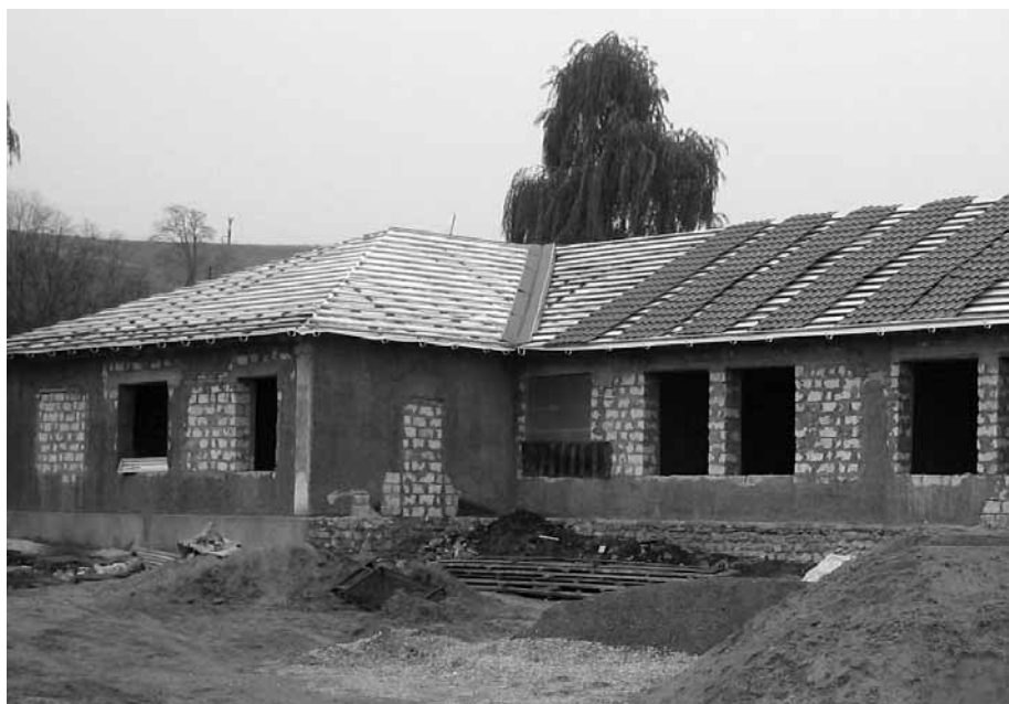
Das im Rohbau befindliche, schon teilweise sanierte Altbau teil der Schule in Milestii-Noi, erhält nun sein Dach.
