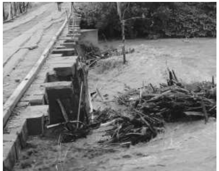
Vor notdürftig reparierten Brücken sammeln sich erneut Treibholz und Tierkadaver.
