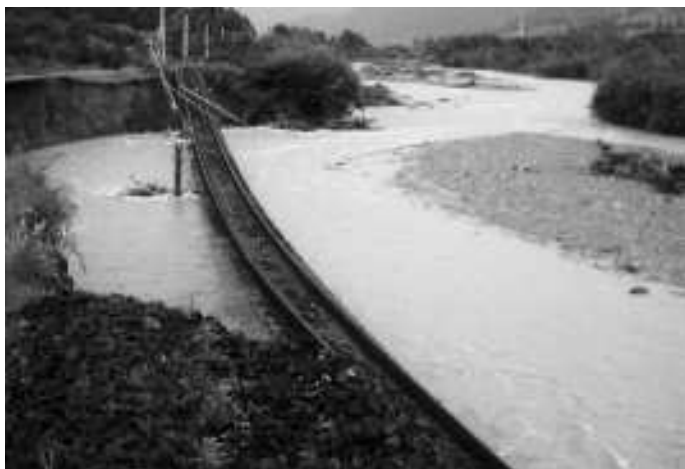
Bahndämme wurden unterspült, wie hier bei Agas in Nordrumänien.
