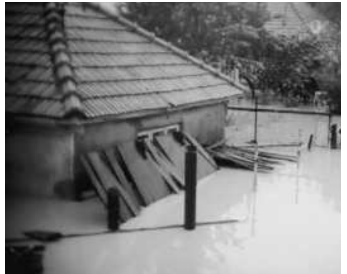
Vom Hochwasser überflutetes Anwesen in der rumänischen Moldau. Die Menschen haben ihre Häuser verlassen. Aus Angst vor Treibgut wurde bei diesem Haus versucht es von außen mit starken Brettern zu sichern.
