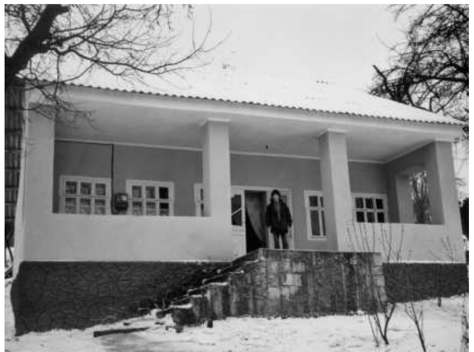
Das renovierte Haus der Familie Chiriac in Cabaesti. Dank der Spenden konnte es nun fertiggestellt werden.
