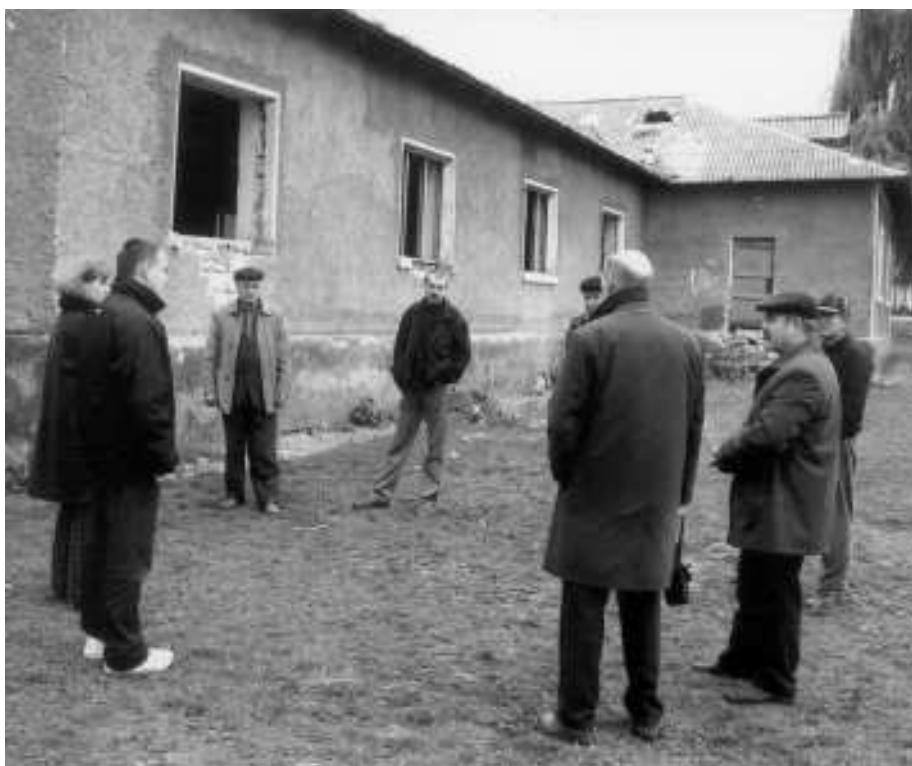
Neuerliche Besprechung mit dem für die Schule verantwortlichen Personenkreis und Architekten in der Moldau. Im Hintergrund das aufgelassene Gebäude, welches in die Bauplanung einbezogen wird.
