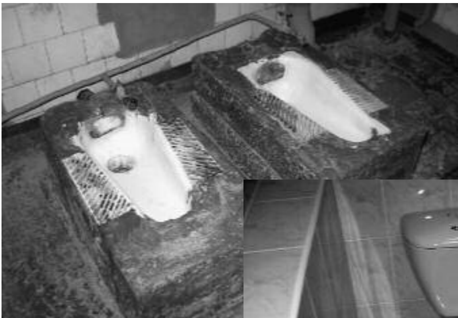
↑ Toilettenanlage der Schule in Leova vor der Renovation. Zu unserem Besuch waren diese gereinigt worden.
