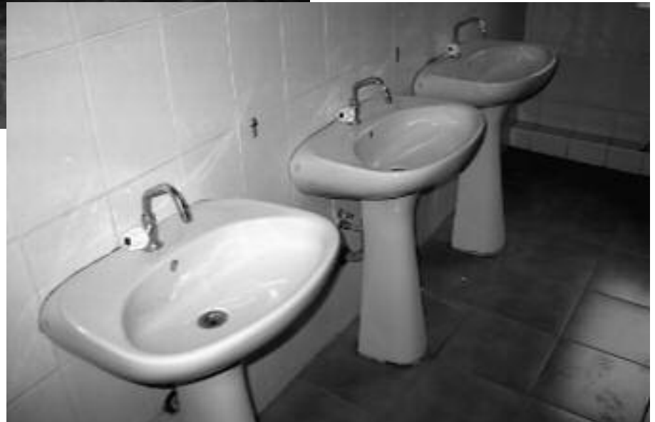
→ Waschraum für die Mädchen nach der Renovation. Wände und Böden sind neu gefliest, die Sanitärhygiene entspricht nun unseren Vorstellungen
