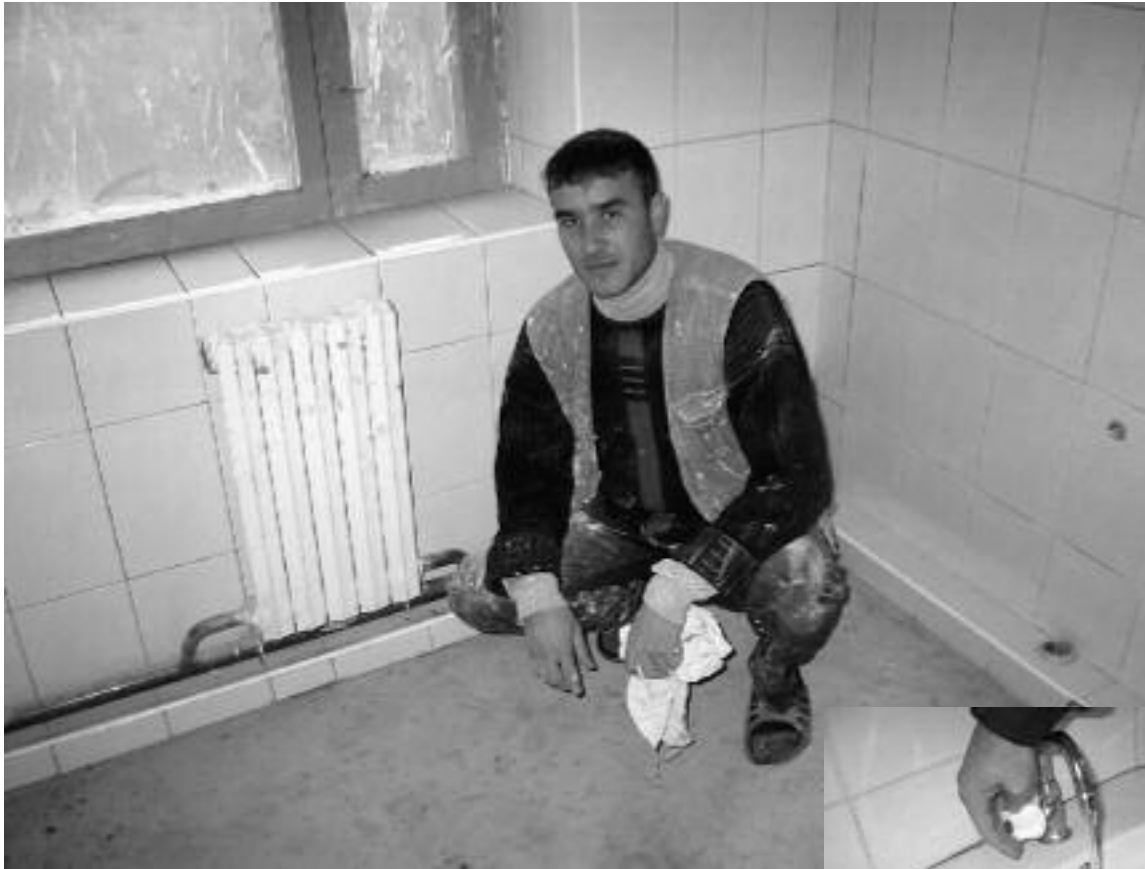
← Fliesenleger beim Bearbeiten der Böden im Duschaum der Internatsschule Leova. Die Arbeiten gehen dem Ende entgegen
