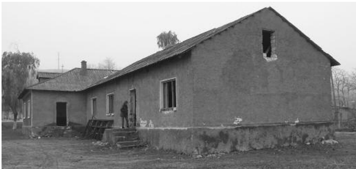
Das neu auszubauende Schulgebäude in Molesti-Noi. An der hier sichtbaren Stirnseite des Baues soll ein Querbau mit 5 Schulzimmern und einer Toilettenanlage angebaut werden.
