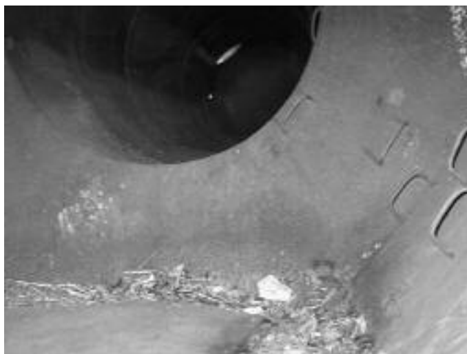
Innenansicht des ehemaligen Wasserturmes der Gemeinde Molesti-Noi. Das Wasserprojekt ist Voraussetzung für das Schulprojekt.
