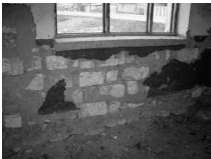
Innenansicht des verfallenen Gebäudes
