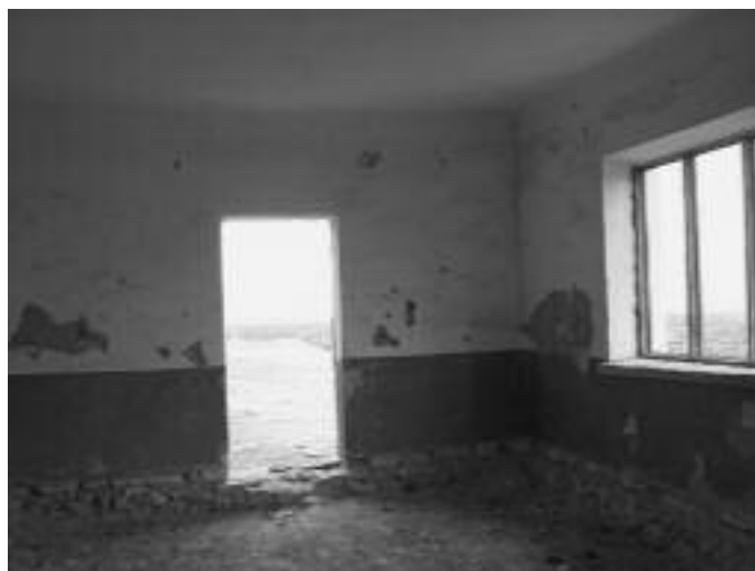
Das Gebäude besitzt noch Naturboden. Sämtliche Fenster und Türen fehlen.
