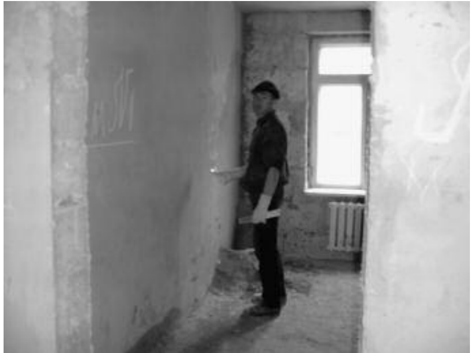
Sanierung eines Krankenzimmers in der Central Klinik in Chisinau, der Raum wird in Krankenzimmer und Nasszelle getrennt, der Grundputz wird aufgetragen.
