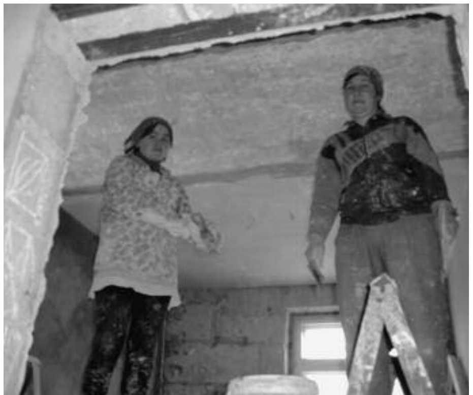
Die Feinputzarbeiten werden überwiegend von Frauen durchgeführt, wobei das gespendete Material der Firma STOTMEISTER verwendet wird.
