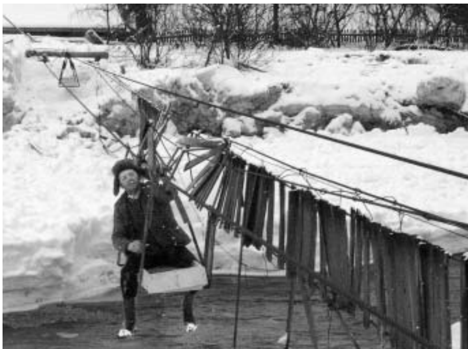
Die Verbindung zu den Ortsteilen ist unterbrochen, da die Brücken weggerissen wurden. Über Stahlseile und einem auf Rollen laufenden Hängerkorb hangeln sich die Menschen über den Fluss. Bild Hartig Jan. 2003
