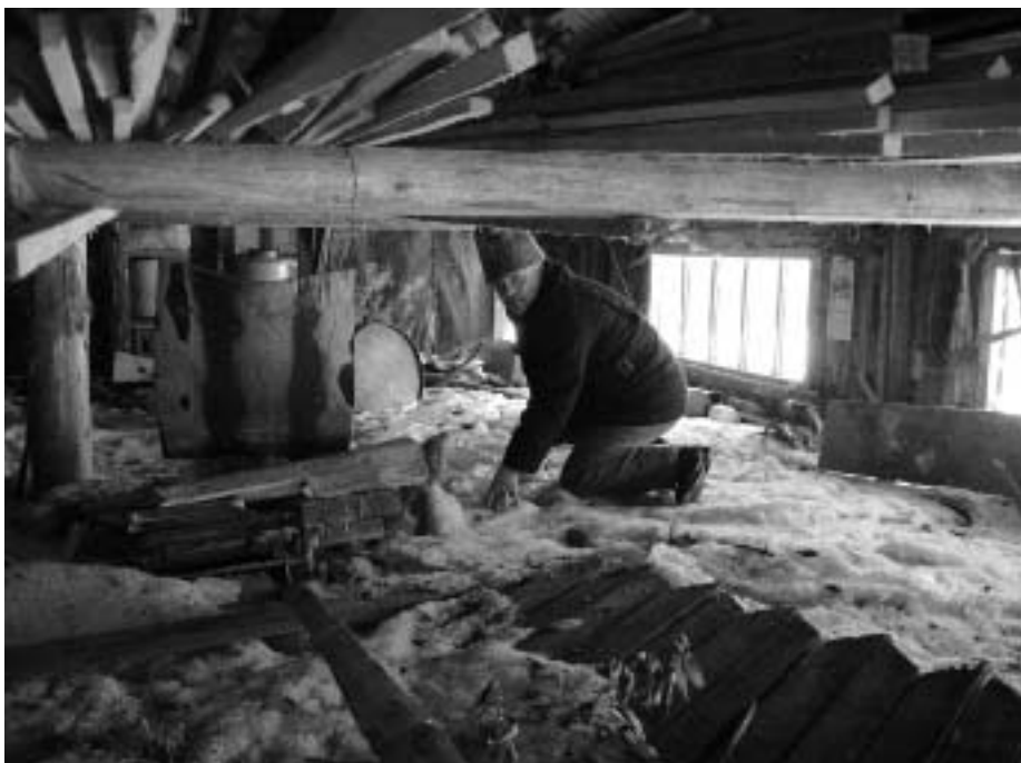
Dieser ehemalige Sägereibesitzer versucht in seiner Werkhalle Reste seines Maschinenparkes zu bergen. Die Gattersäge und alle anderen Maschinen sind bis zum Dach hin in Eis eingeschlossen.
