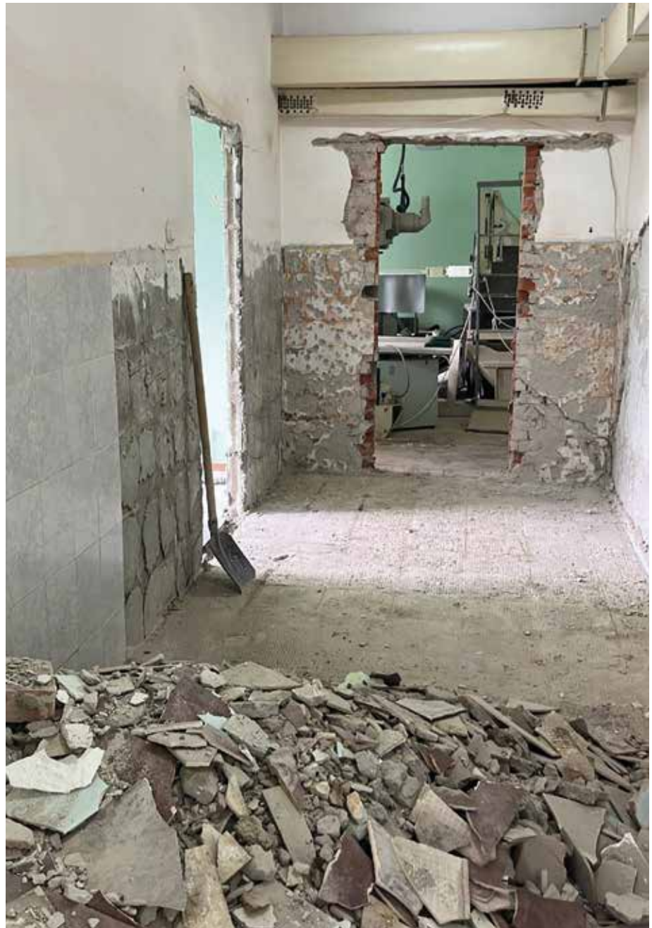
■ Es ist ersichtlich, welche massiven Bauarbeiten vorgenommen werden müssen.
