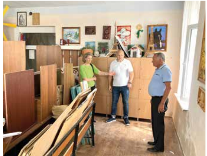
■ V.l.n.r. unsere Mitarbeiterin Marina, Sergiu Artene, der Bauunternehmer Ilie Corobca, bei der Besichtigung der Baustelle.
