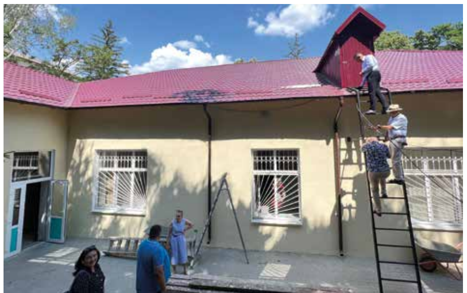
■ Im Innenhof erkennt man, dass das Dach, sowie die restliche Gebäudestruktur einer Totalrenovation unterzogen wurde. Auf der Leiter befinden sich: ganz oben Sergiu Botnaru, in der Mitte, Dirk Hartig, unten, Oleg Caminschi bei der Bauabnahme.
