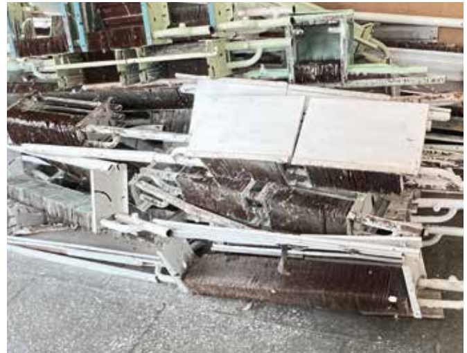
■ Die Bauarbeiten sind bereits voll im Gange. Total archaische Heizkörper wurden bereits entfernt. Bilder: Pro Humanitate
