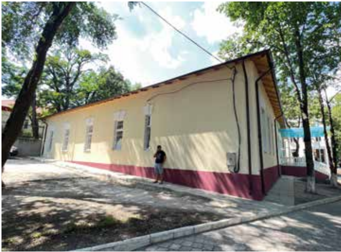
■ Das Eckgebäude der medizinischen Schule in Orhei ist mittlerweile fertig gestellt. Stahlträger, Verputzarbeiten, innen und außen, sowie das Dach wurden erneuert.
