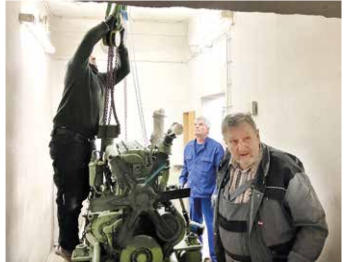
■ Der technische Mitarbeiter des Jugendwerkes Gailingen hilft uns den Generator in der Waage zu halten. Einer der drei aus Moldau angereisten Techniker achtet auf die Deckenbelastung.
