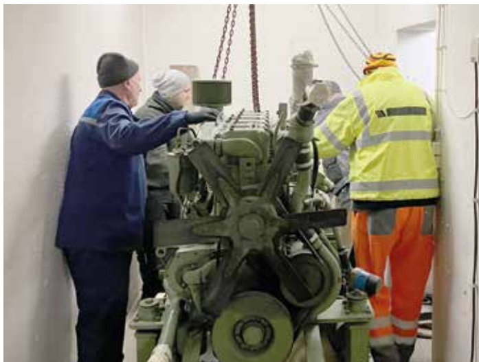
■ Mit vereinten Kräften wird der Generator von seinem Podest angehoben.
