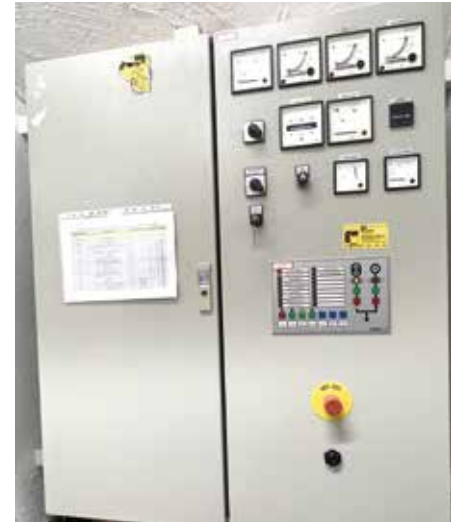
■ Die komplette Schaltanlage des Generators. Sie weist eine Betriebsdauer von nur 131 Stunden aus.
