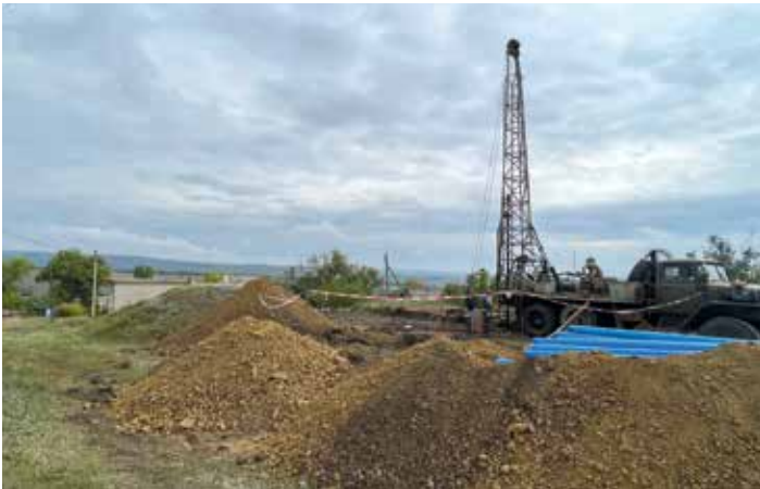
■ Der Beginn der Arbeiten erforderte erhebliche Erdbewegungen
