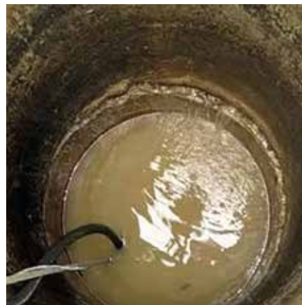
■ Zustand eines Trinkwasserbrunnens in Lozova vor unseren Baumaßnahmen
