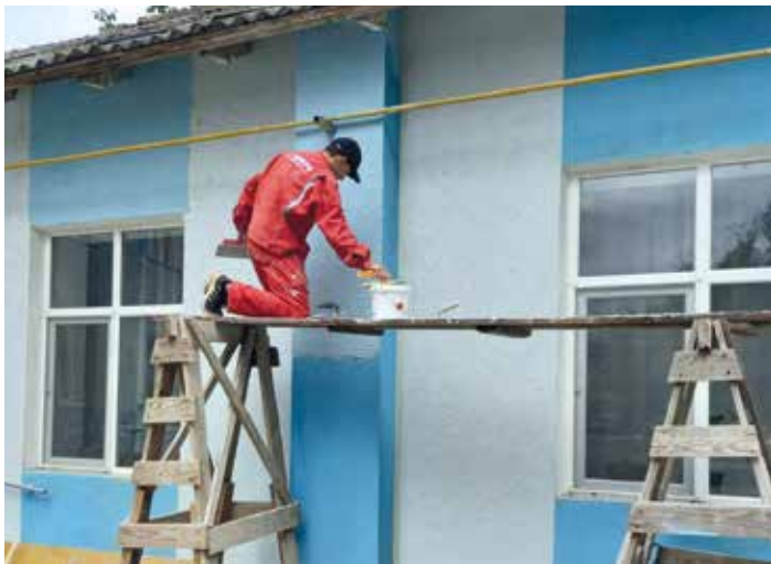
■ Ein angehender Stuckateur bei der Arbeit
