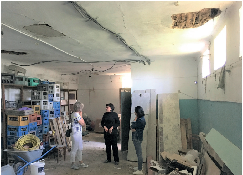
■ Dieser Raum im hinteren Teil der geplanten Suppenküche muss komplett saniert und mit den notwendigen Gerätschaften ausgerüstet werden. V.l.n.r. unsere Mitarbeiterin Marina, die Bürgermeisterin Elena Margianu und eine Sozialhelferin, bei der Besprechung unserer geplanten Aktivitäten.
