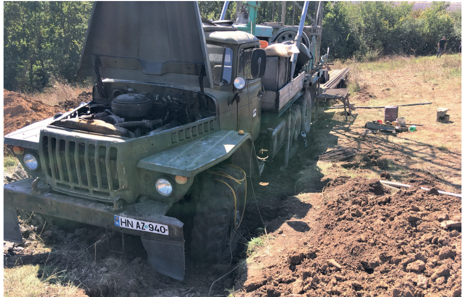
■ Das „Bohrgerät in COBILEA. Ich bin immer wieder erstaunt, dass diese Technik funktioniert.
