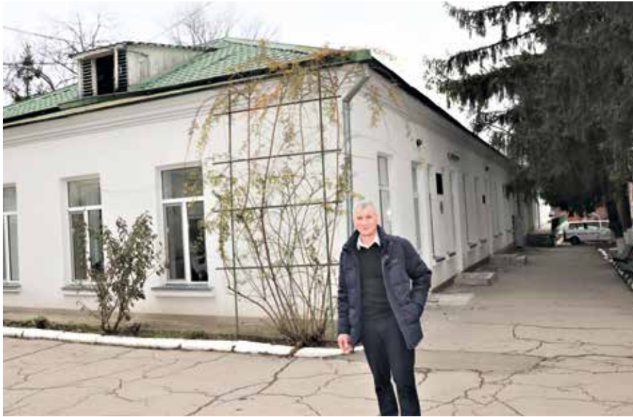
■ Renovierte Außenansicht eines Klinikkorpus der Verbrennungsklinik E. Cotaga.
