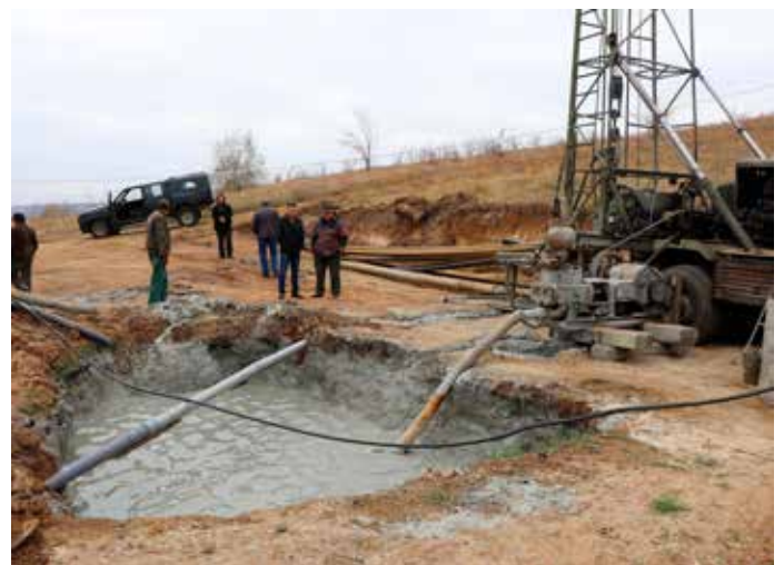
■ Das Spülbecken für die Tiefbohrung ist in Betrieb.
