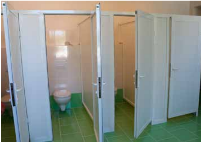
■ Die neuerstellte Toilettenanlage für Mädchen in Mingir
