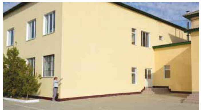
■ Das mit Verputzmaterialien der Firma STOTMEISTER renovierte Krisenzentrum in der moldauischen Stadt Comrat. Marina ist stolz über das rasche Ergebnis der Baumaßnahme
