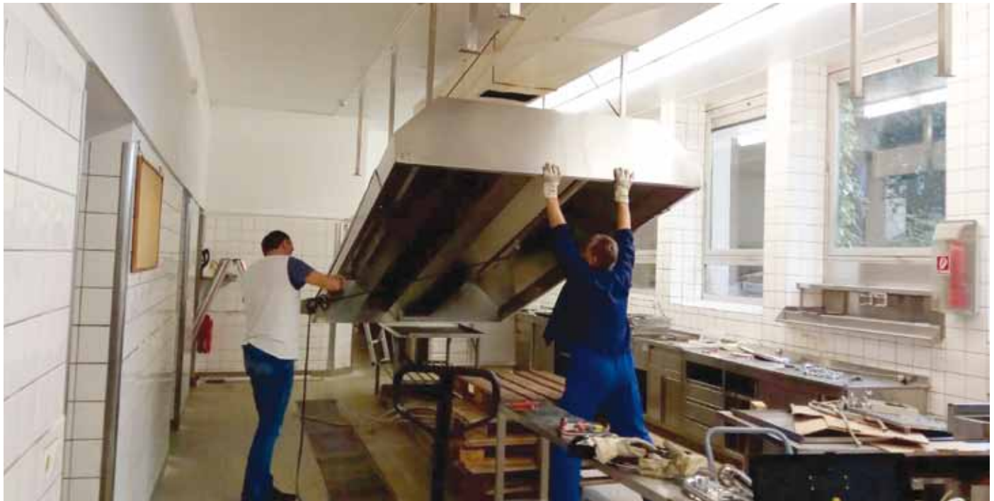
■ Die aus Moldau angereisten Techniker bei der Demontage der unglaublich schweren Küchenabzugshaube des ehemaligen Spitales in Rottweil
