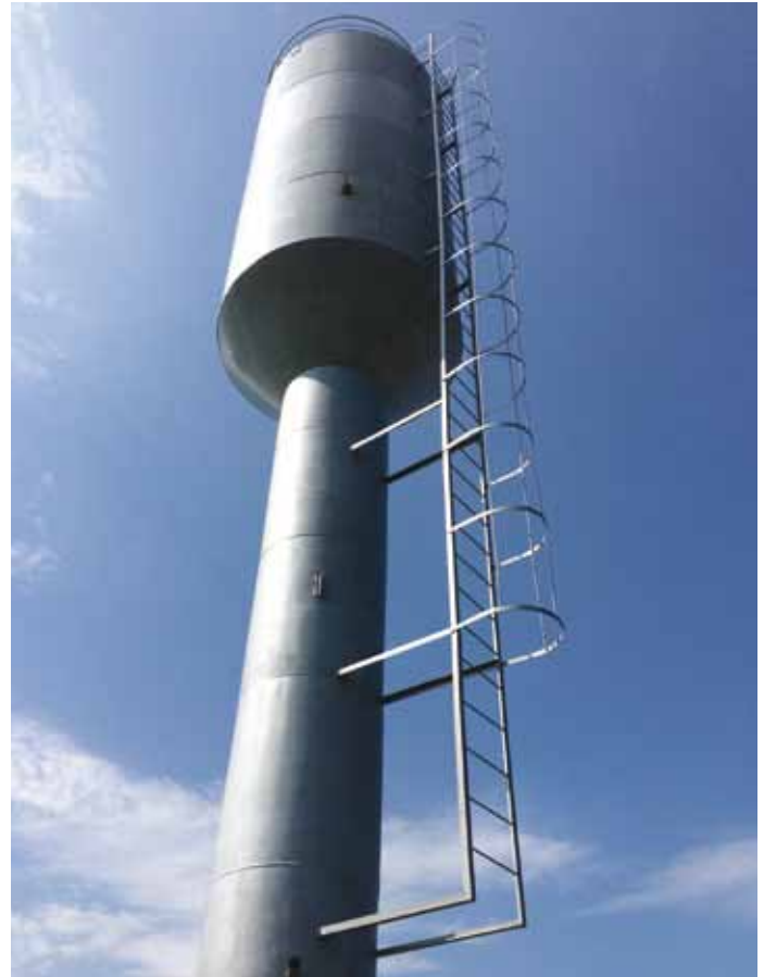
■ Der neu erstellte Wasserturm für unser Projekt in Hirbovat.
