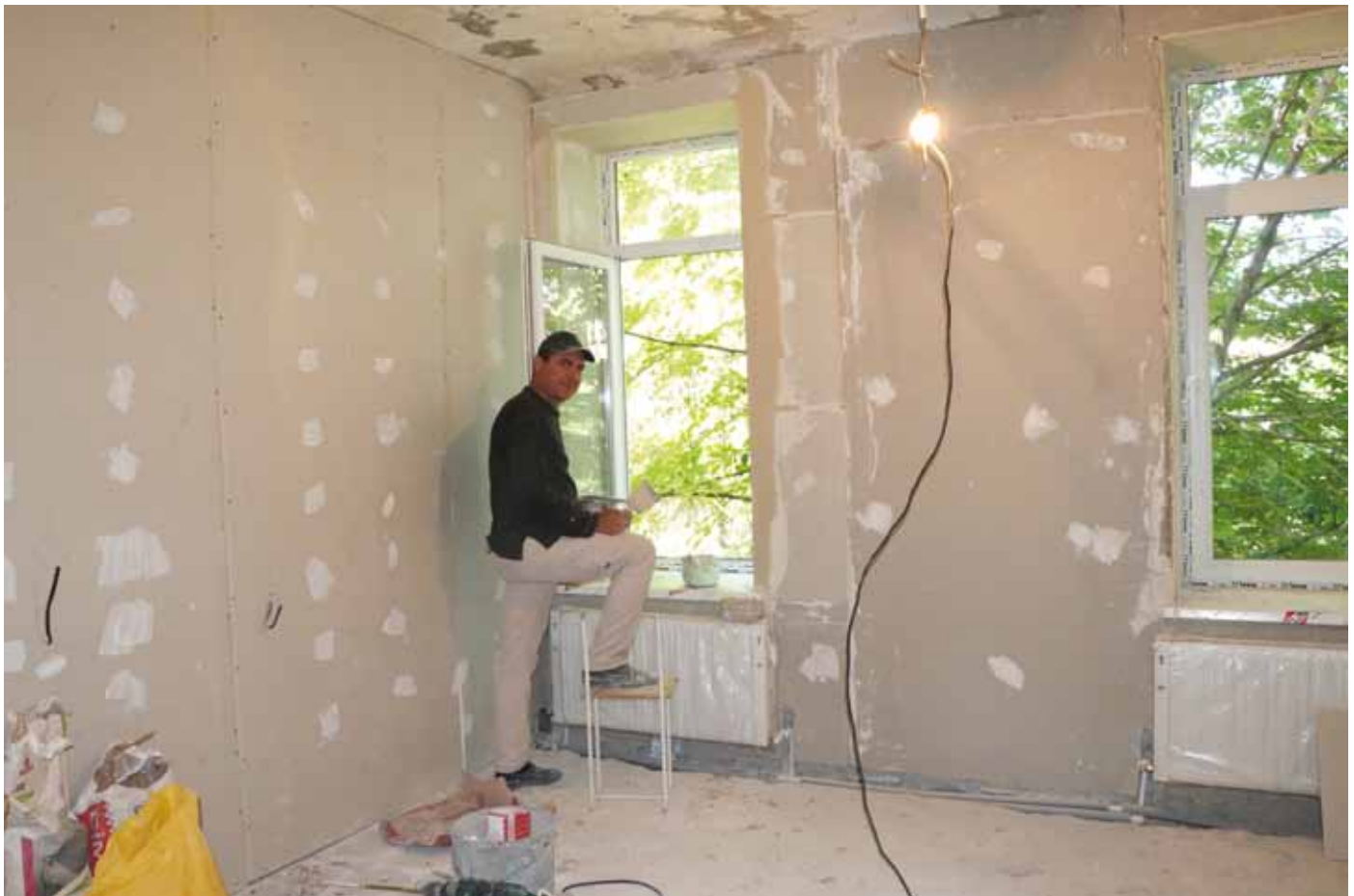
■ Der Aufenthaltsraum des Sozialzentrums in Costesti/Moldau im Entstehen.
