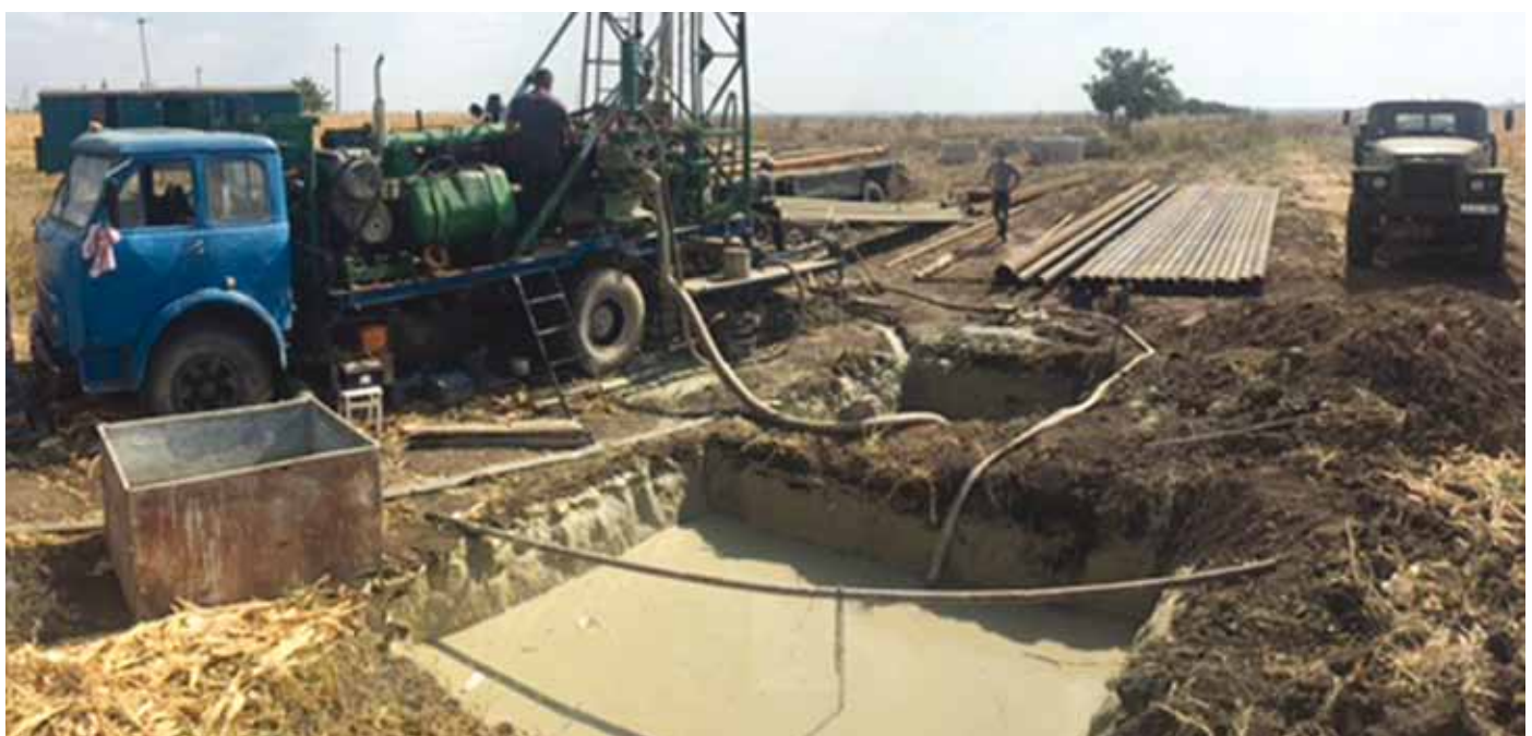
■ Der Tiefbrunnenbau in Hirbovat ist in Arbeit. Das Spülwasserbecken für die Bohrung und die Bohrgestänge sind sichtbar.
