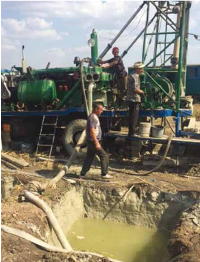
■ Die Bohrarbeiter bei sengender Hitze und schweißtreibender Arbeit.
