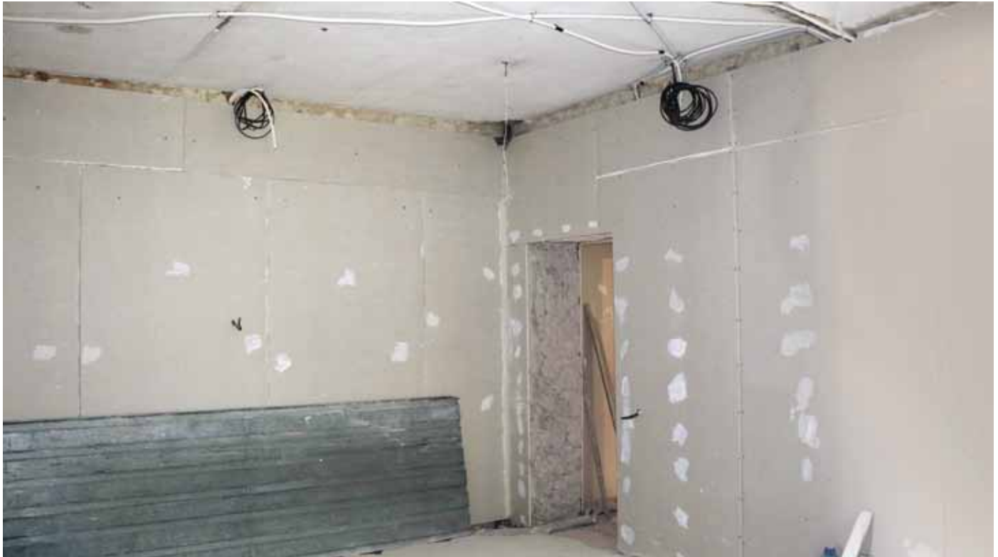
■ Der Rohbau des Küchentraktes ist im Werden.
