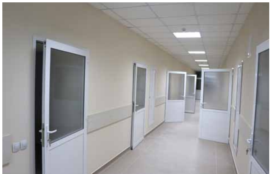
■ Eine fertig sanierte Etage der Klinik Mutter und Kind.
