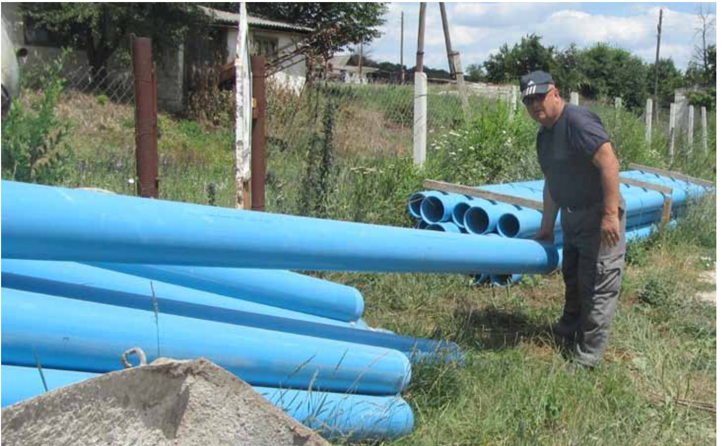
■ Der Bohrmeister Ion Stefanaru mit den angelieferten Steigeleitungen.
