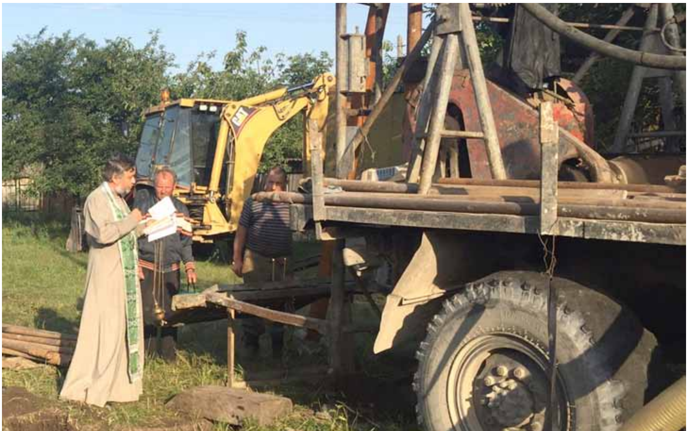
■ Traditionell wird in Moldau jede Wasserbohrung zu Beginn von einem Geistlichen gesegnet.
