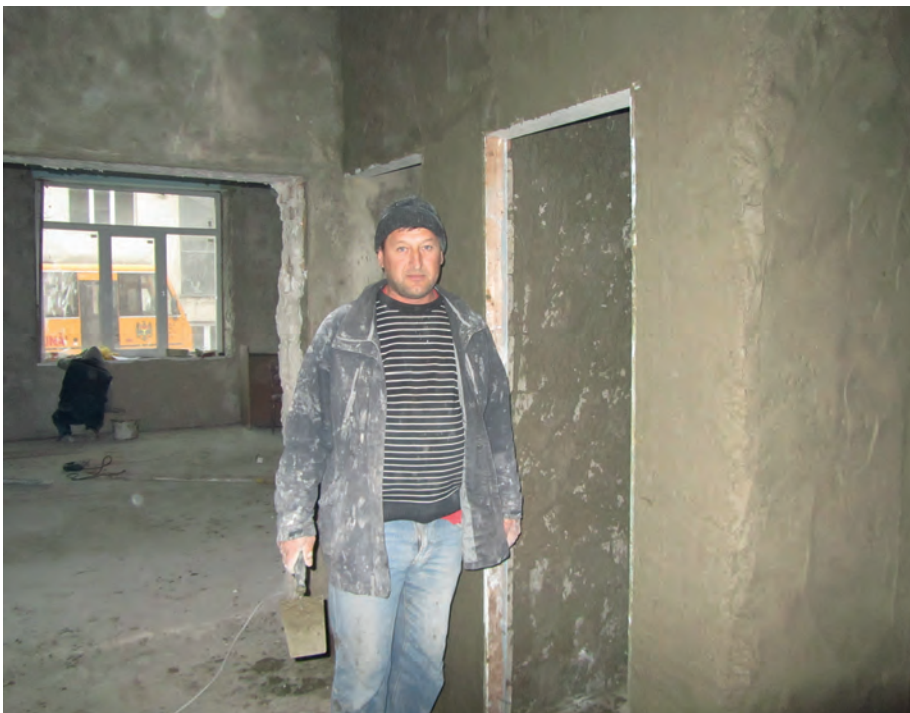
■ Der Innenausbau geht zügig voran. Wegen des herannahenden Winters war es notwendig geworden erst die Außenarbeiten zu erledigen. Bilder: Hartig
