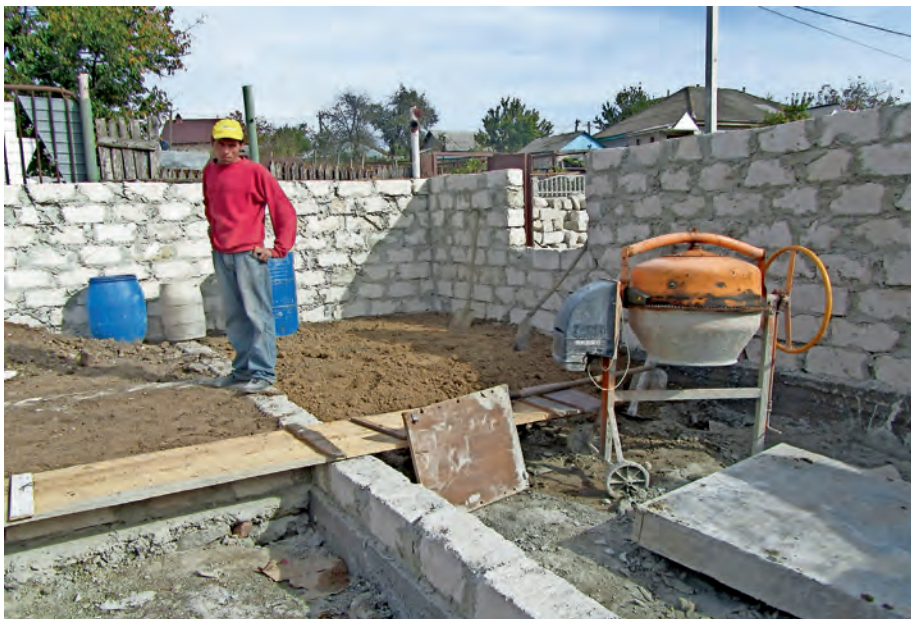
■ Ansicht des Grundaufbaus des Anwesens Raiu in Nimoreni. Das Wetter spielt mit und die Bauarbeiten schreiten zügig voran. Bild: I. Luchian
