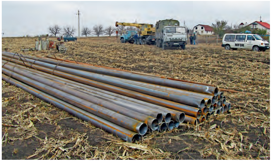
■ Nach längerer Suche durch Sachverständige wurde dieser Platz als Bohrstelle ausgewählt. Das Maisfeld wurde bereits geerntet. Die Baustelle wird eingerichtet. Die Versorgungsrohre sind bereits angeliefert. Unser in Moldau befindlicher VW-Bus versteht trotz seines Alters von 16 Jahren seinen Dienst hervorragend und ist für unsere vielfältige Arbeit unverzichtbar geworden. Noch ist Dank des ausgebliebenen Regens der Boden mit schwerem Gerät befahrbar.
