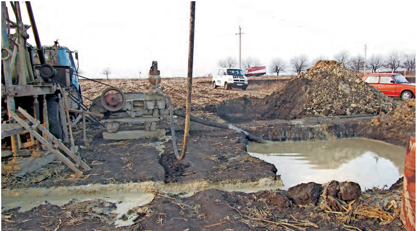
■ Der Bohrturm im Einsatz. Im Vordergrund das für die Bohrung notwendige Spülwasser. Das Bohrggerät selbst kann als antiquarisch bezeichnet werden. Es ist sehr einfach aber es funktioniert. Bild: Ion Luchian
