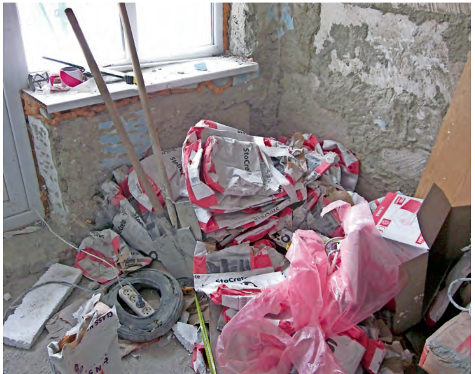
■ Die neuen Fenster sind eingesetzt. Ebenfalls die Fensterbretter. Das durch STO gespendete Verputzmaterial war voll umfänglich ausreichend. Im Bild erkennbar die leeren Papiersäcke mit STO-CRETE. Die Bauarbeiter waren über das angelieferte Baumaterial begeistert. Bild: Hartig
