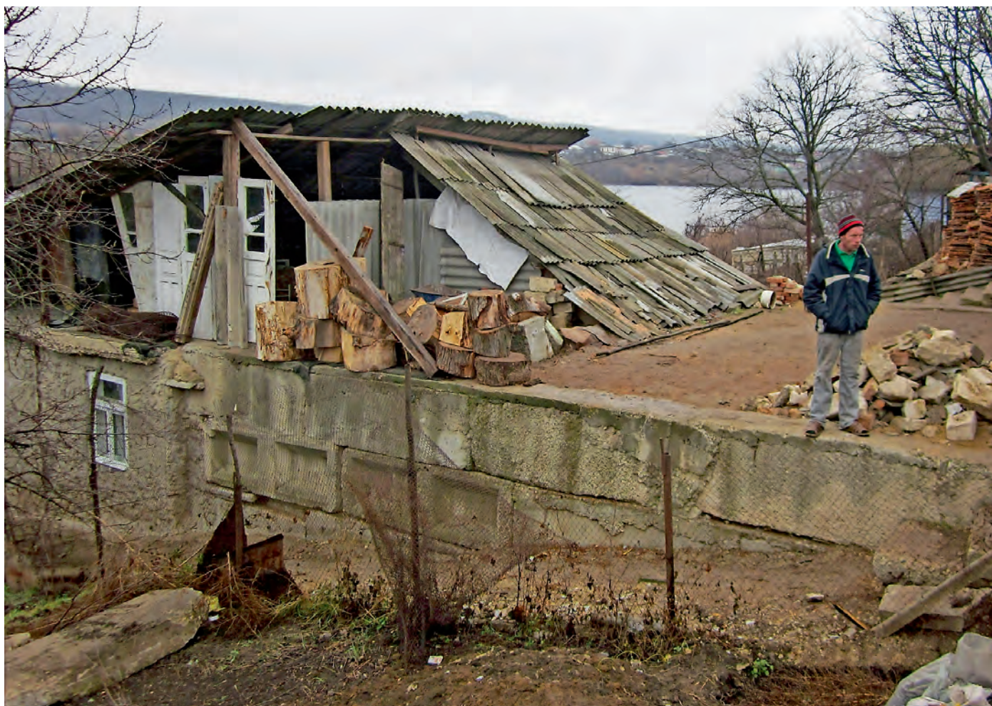
■ Dieses Bild, welches wir auch in unserer vergangenen Ausgabe der Verbandsnachrichten zeigten, stellt „die Villa Raiu am See“ in Nimoreni dar. Wir hoffen bis zum Spätherbst das Anwesen mit der Spende aus Gottmadingen bewohnbar machen zu können. Bereits jetzt zeigt sich jedoch, dass das Dach höhere Kosten verursachen wird, da auch in Moldau Eternitplatten wegen Asbestgefahr nicht mehr verwendet werden dürfen. Bild: Hartig
