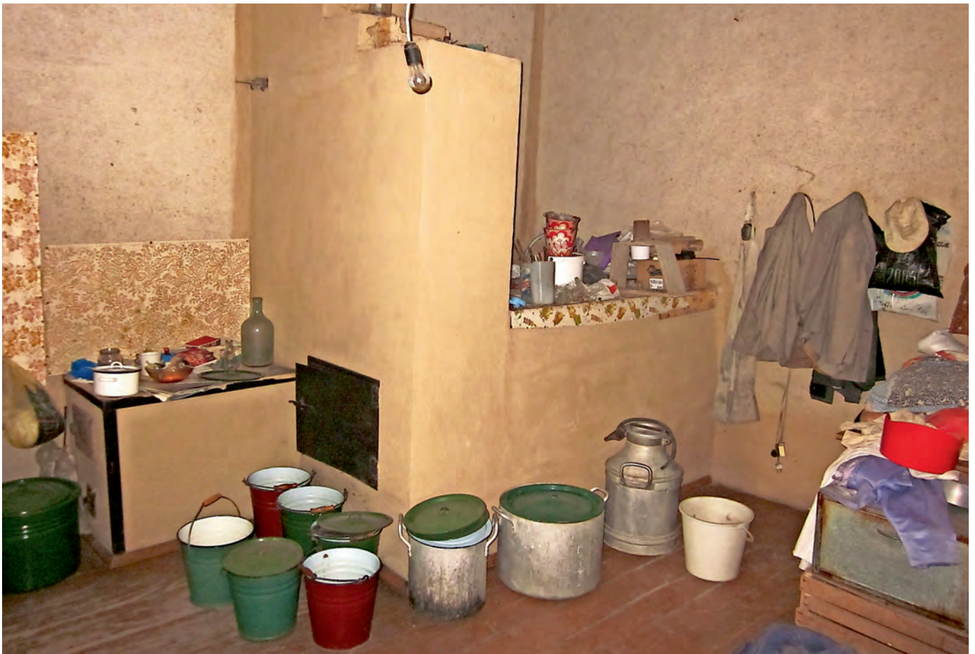
■ Ein Teil dieses Gebäudes stand kurz vor der Renovation. Im Bild erkennbar der typisch moldauische Ofen, bestehend aus Herd, gemauertem Kamin und rechts den Schlafplätzen. Die Eimer dienen der Wasserbevorratung. Während der Renovation verstarb der Inhaber. Seine Frau zog in den Landesteil Transnistrien zu ihren Kindern.
