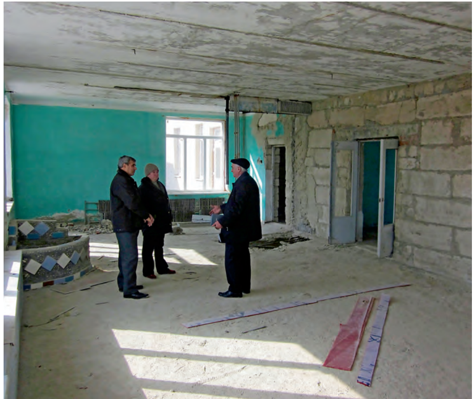
■ Die entkernte Räumlichkeit der durch uns zu erstellenden Sozialküche in Gangura. Wir besichtigten den baulichen Zustand und kalkulieren die anfallenden Kosten.
