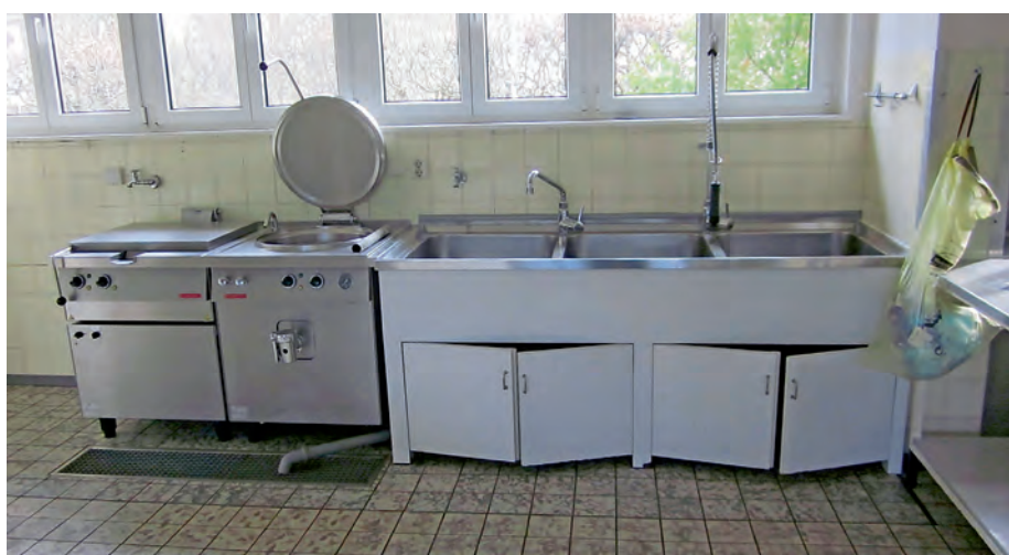
■ Im Bild oben ist die Spülmaschine erkennbar. Das mittlere Bild zeigt einen Elektroherd und zwei Gasherde. Das untere Bild Kocheinrichtungen für Suppen, Garkocher und Spüle. Bilder: Hartig
