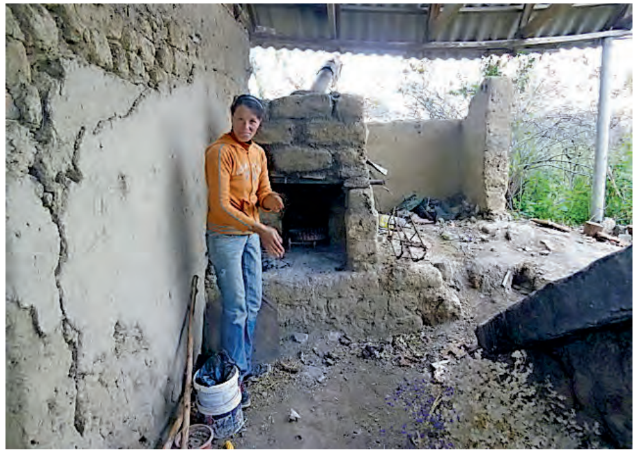
■ Frau Gorgan erklärt uns gestenreich, dass sie kein Brennholz mehr habe. Hinter ihr ist der Backofen dieses äußerst baufälligen Anwesens zu sehen.
