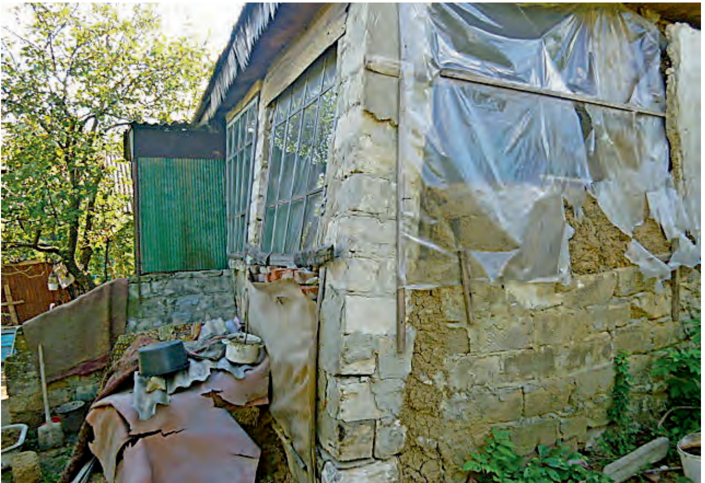
■ Außenansicht eines Anwesens in Nimoreni. Eine alleinstehende Mutter versuchte mit Lehm, Maisstroh und Dung Ziegel zu formen um die Hauswände damit zu stabilisieren. Es fehlt in diesem Anwesen an allem. Bild: Hartig
