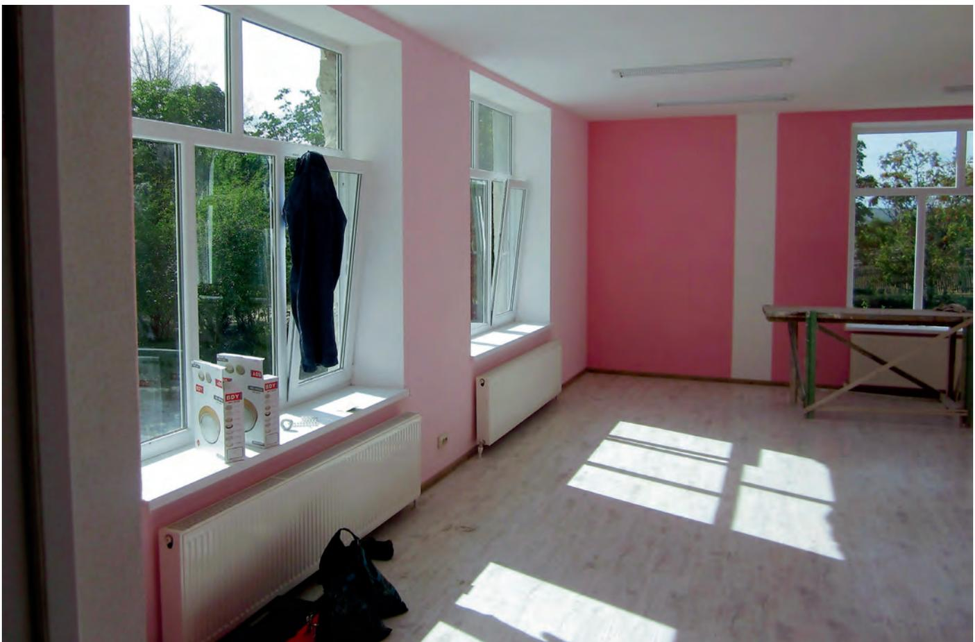
■ Der fast fertiggestellte Raum. Die Decke und Lampen sowie die Heizkörper sind bereits installiert, die Wände gestrichen.
