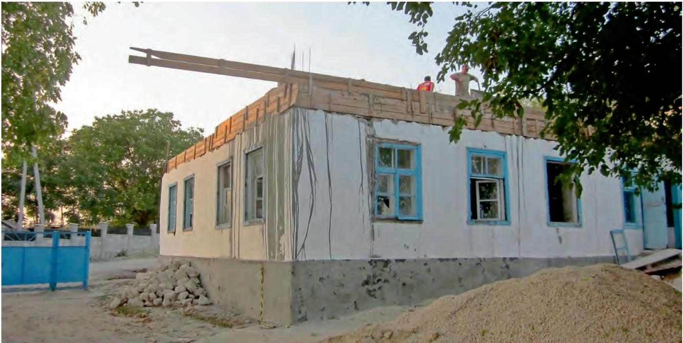
■ Ein Teilflügel der Schule in Zimbreni ist bereits mit den Deckenplatten versehen worden. Ein Betongürtel wird gerade gegossen. Vor dem Wintereinbruch soll auch noch das Dach fertig werden. Bild: Hartig
