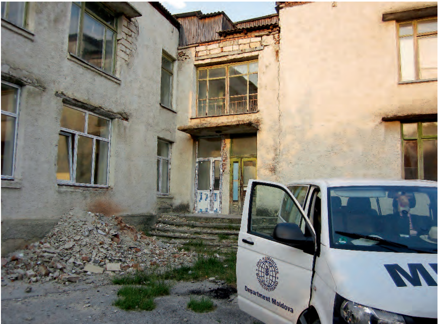
■ Aussenansicht des Kindergartengebäudes in Pirjolteni. Die Innenräume sind teilweise fertig. Neue Thermopfenster und eine Türe sind bereits eingebaut.
