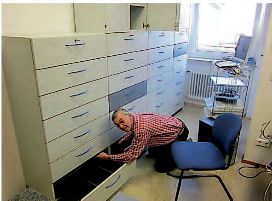
■ Unser mittlerweile schon „eingefuchster“ Mitarbeiter Wilfried Kopp beim Demontieren. Das Material ist außergewöhnlich gut und fachmännisch eingebaut worden.
